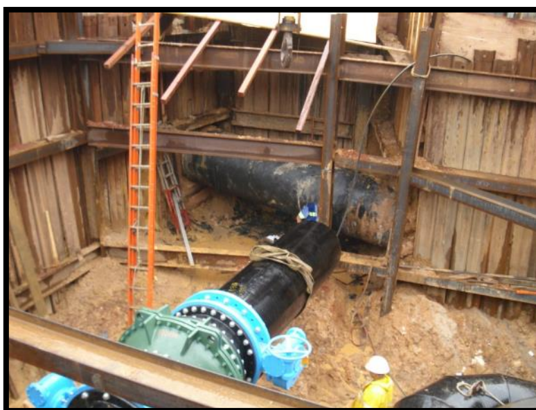
Foto 3 – Vista geral da interligação com a adutora
