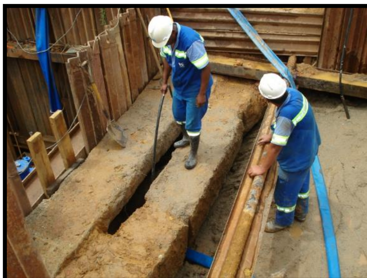
Foto 5 – Compactação via úmida com vibrador
