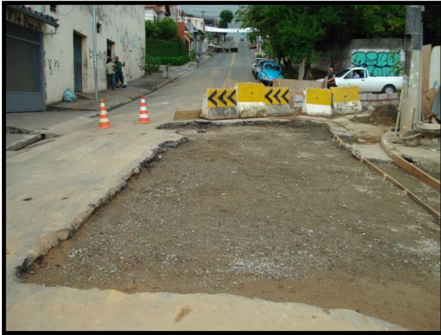
Foto 8 – Vista do aterro da vala finalizado
