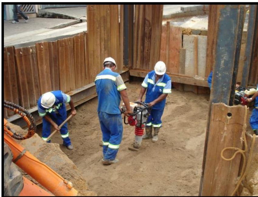
Foto 7 – Compactação das camadas do reaterro da vala
